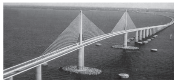
Figura 9. Tirantes de un puente, aplicación del teorema de Pitágoras.
